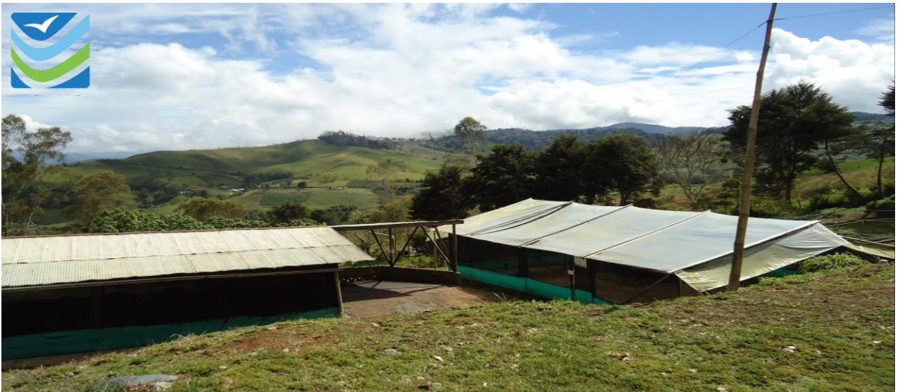
Foto Vallecaucana de Aguas S.A.-E.S.P/ PMIRS Versalles – Valle del Cauca
