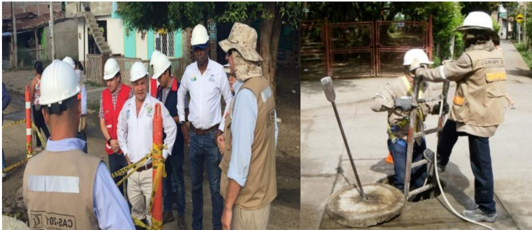
Alcantarillado – Corregimiento de Sonso – Municipio de Guacarí
