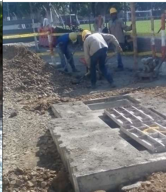
RELLENO AREA ANEXA A LA EBAR CONSTRUIDA.
