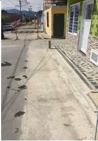
Reposición de andenes
