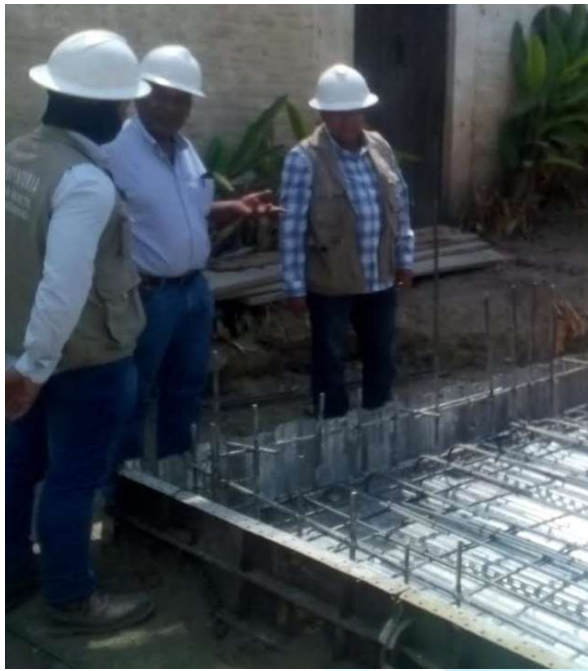
CONSTRUCCION LOSA DE CUBIERTA DE LA EBAREBAR
