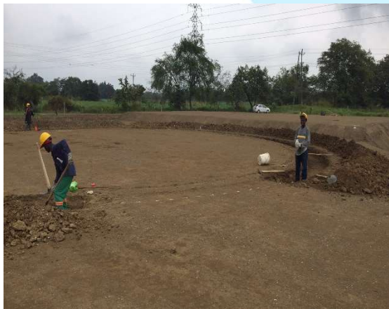
Excavación manual para la fundición del refuerzo losa del tanque de almacenamiento
