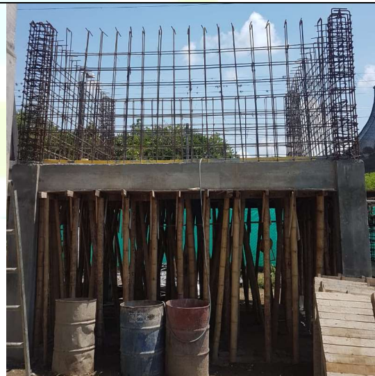
CONSTRUCCION DEL TANQUE DE CARGA.
