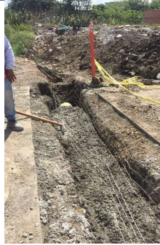
Recubrimiento tubería, manejo de aguas lluvias
