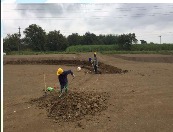
Excavación manual para la fundición del refuerzo losa del tanque de almacenamiento
