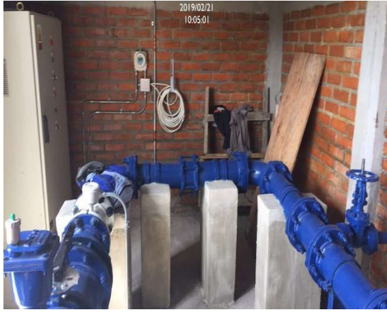
Accesorios, macromedidor, Valvulas de golpe de ariete y Gabinete eléctrico de la Estación de Bombeo del pozo La Victoria.
