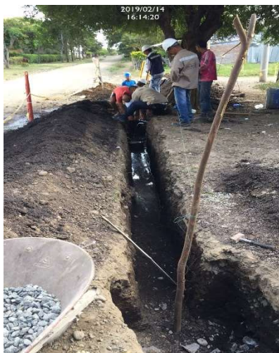
Excavación para instalación de tubería
