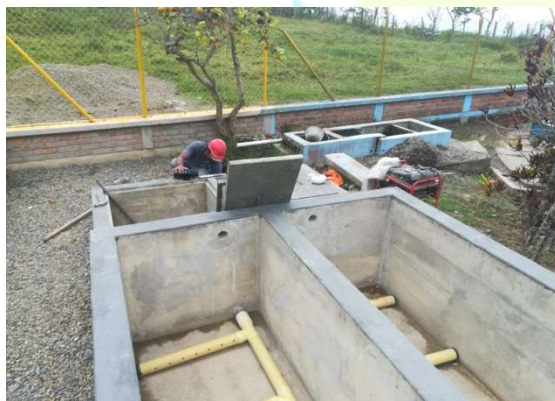
Recorrido estructuras PTAP San Isidro - El Chuzo - Filtro Grueso
