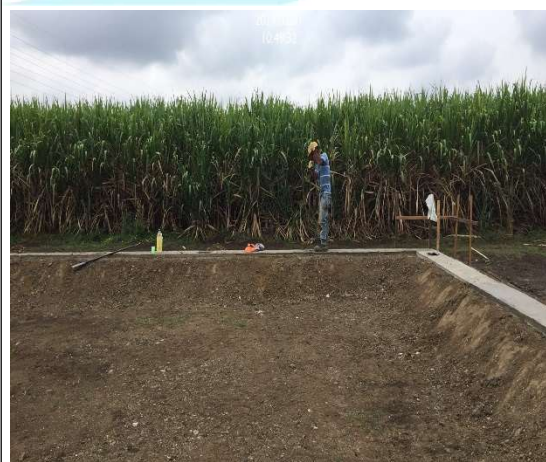
Fundición solado cerramiento perimetral
