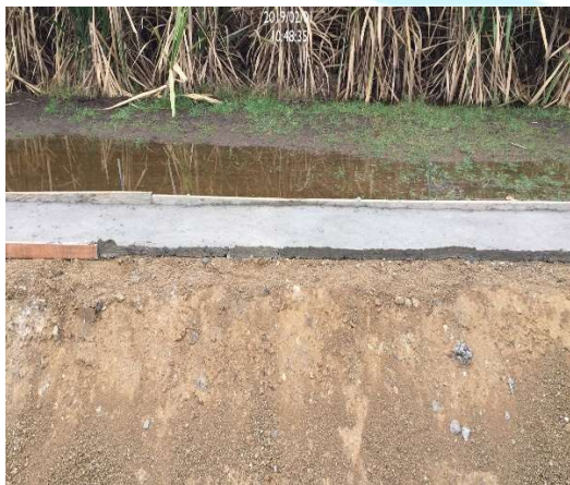
Fundición solado cerramiento perimetral
