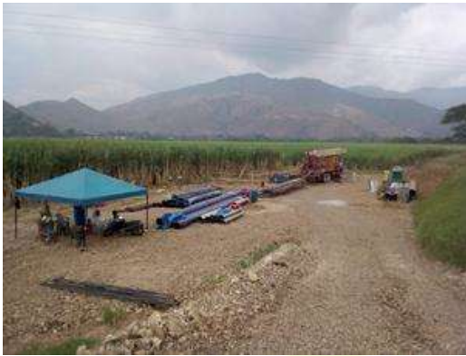
Instalación de la máquina perforadora
