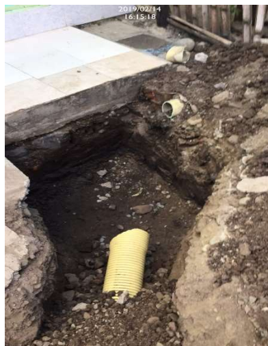
Construcción de pavimento
