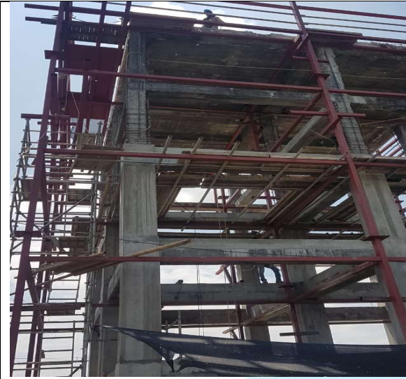
PREPARANDO LOS ANDAMIOS PARA EL PROCESO DE REFORZAMIENTO DE VIGAS Y COLUMNAS DE CUARO NIVEL.
