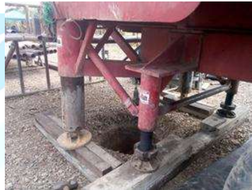
Inicio de perforación para prueba de bombeo
