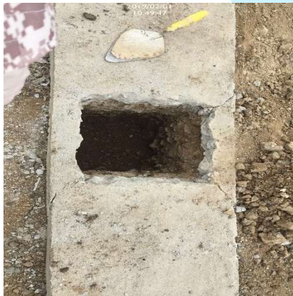
Excavación manual para los postes metálicos del cerramiento perimetral
