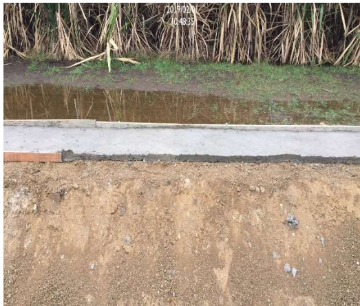
Fundición solado cerramiento perimetral
