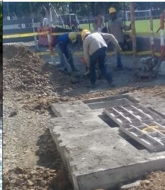
RELLENO AREA ANEXA A LA EBAR CONSTRUIDA.
