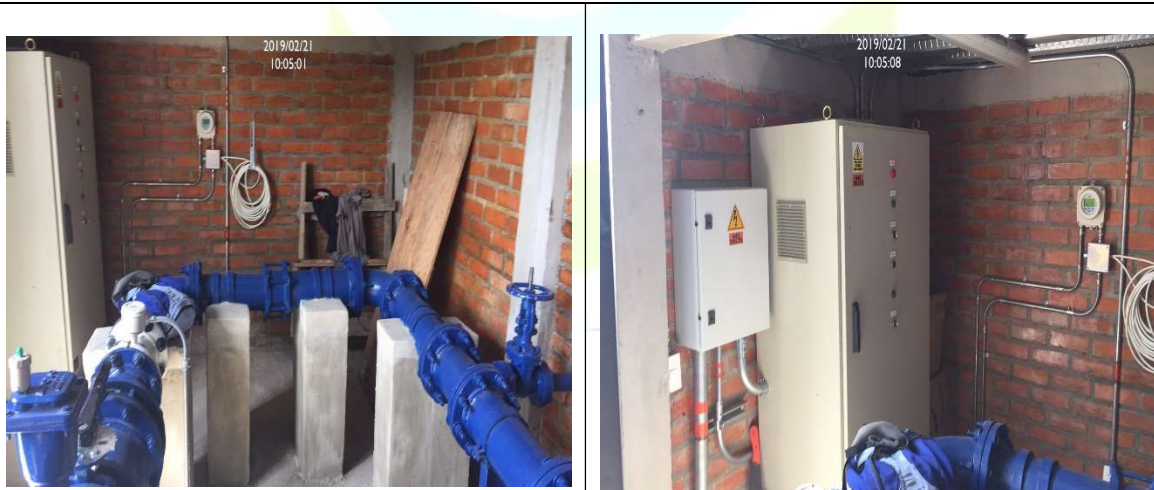
Accesorios, macromedidor, Valvulas de golpe de ariete y Gabinete eléctrico de la Estación de Bombeo del pozo La Victoria.
