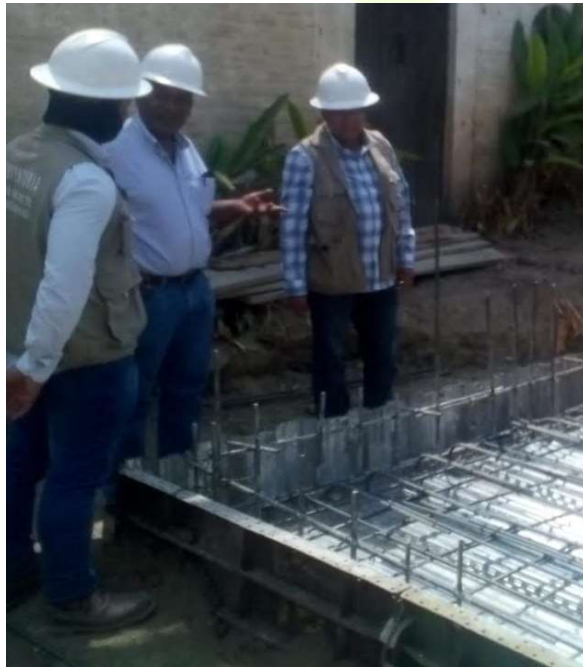
CONSTRUCCION LOSA DE CUBIERTA DE LA EBAREBAR
