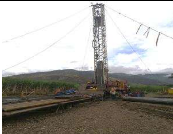
Máquina perforadora del pozo
