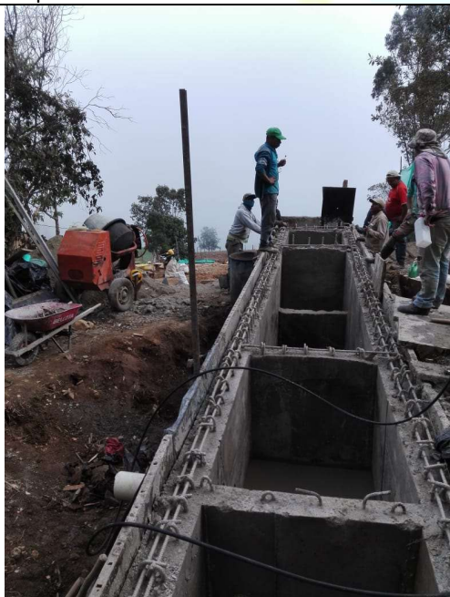
Fundición de Desarenador
