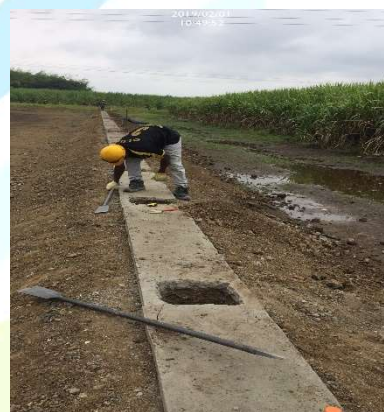
Excavación manual para los postes metálicos del cerramiento perimetral
