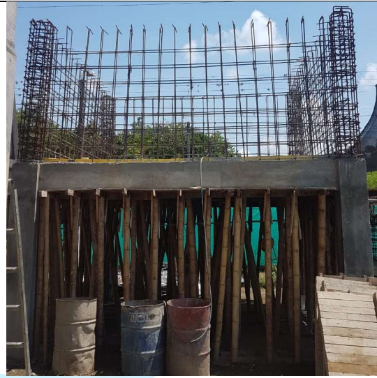
CONSTRUCCION DEL TANQUE DE CARGA.
