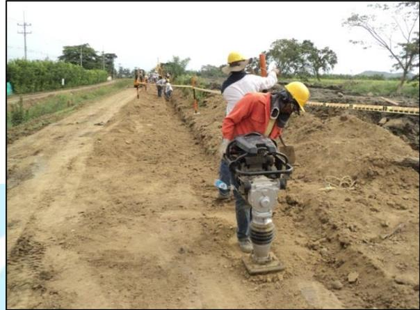
Relleno compactado posterior a la instalación
