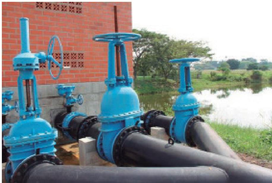
Para ello fue necesario realizar la construcción de un pozo de succión en concreto reforzado, una caseta de operación y un cuarto de máquinas en ladrillo limpio con cubierta en teja trapezoidal, dos bombas verticales eléctricas y una bomba con motor diésel. Así mismo se realizó la acometida eléctrica de media tensión, con un transformador y un sistema de medición con tablero de control y tablero de potencia y una estructura de disipación de energía en la descarga”, puntualizó.
