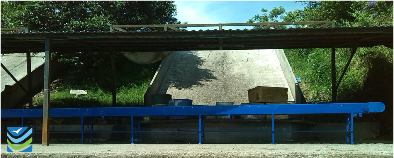
Foto Vallecaucana de Aguas S.A.-E.S.P/ Banda Transportadora, PMIR de Alcalá -Valle del Cauca
