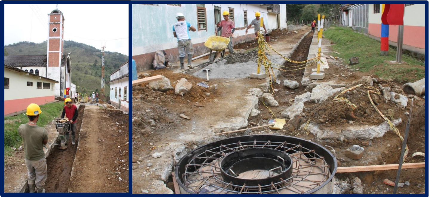
Obras de reconstrucción y optimización del sistema de alcantarillado del corregimiento La María - Municipio de El Águila
