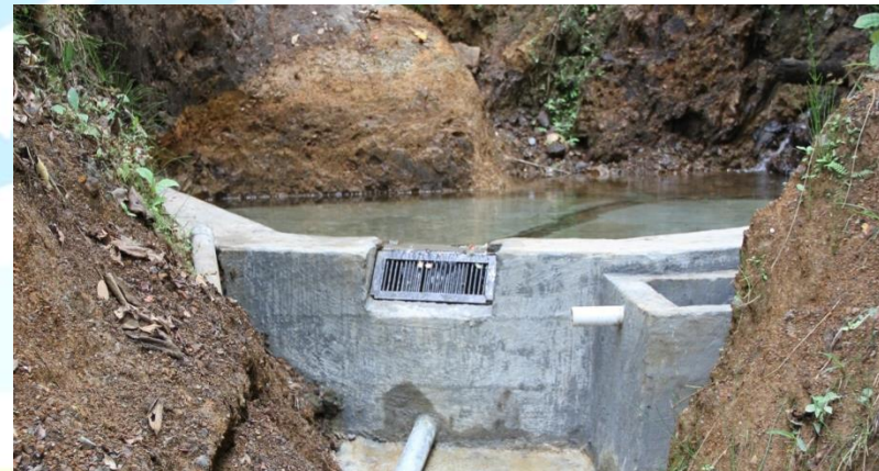
Vallecaucana de Aguas / Bocatoma acueducto La María- Municipio de El Águila
