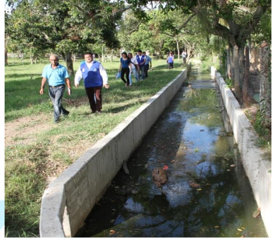
Foto / Gerente Carlos Eduardo Calderón Visita inspección de obra
