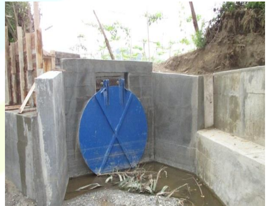
Foto / Cabezal de entrega de alcantarillado pluvial al río Toro
