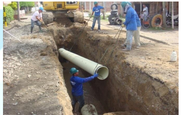
Foto/ Vallecaucana de Agua- Instalación del relleno del material filtrante en Agua Clara
