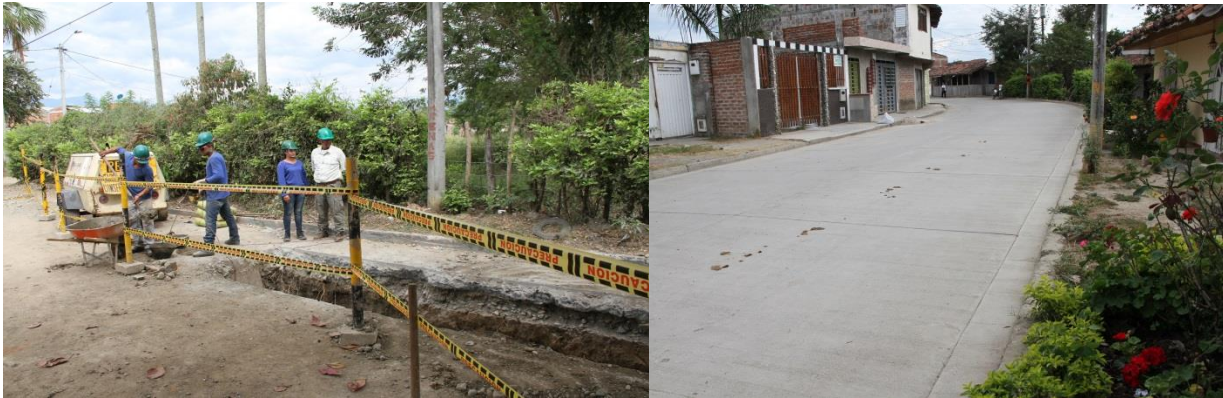
Vallecaucana de Aguas/Obras de Alcantarillado en el Corregimiento de Agua Clara - Tuluá
