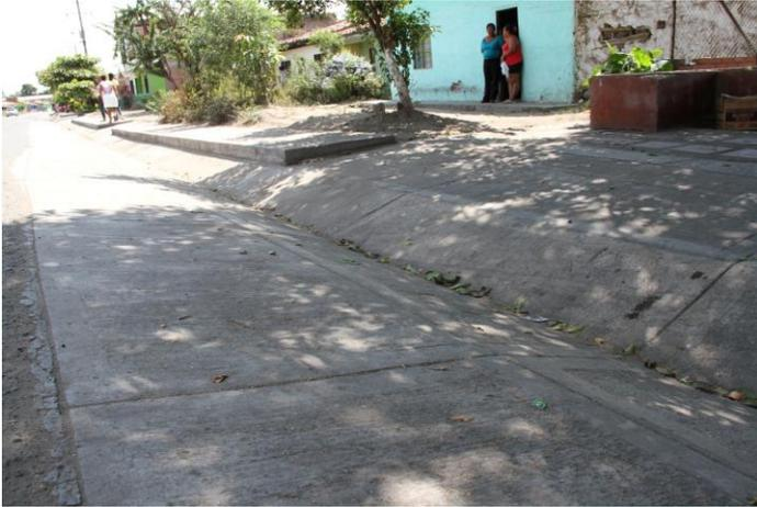
Carlos Eduardo Calderón Llantén, Gerente de Vallecaucana de Aguas, explicó que en desarrollo del proyecto, se construyeron 729,42 metros lineales de canales de evacuación de las aguas lluvias con 147.94 M<sup>3</sup> de concreto, lo cual conllevó a la instalación de 2.900 Kg de malla electrosoldada y la construcción de 257 metros lineales de sardinel trapezoidal en concreto, permitiendo que los habitantes de
