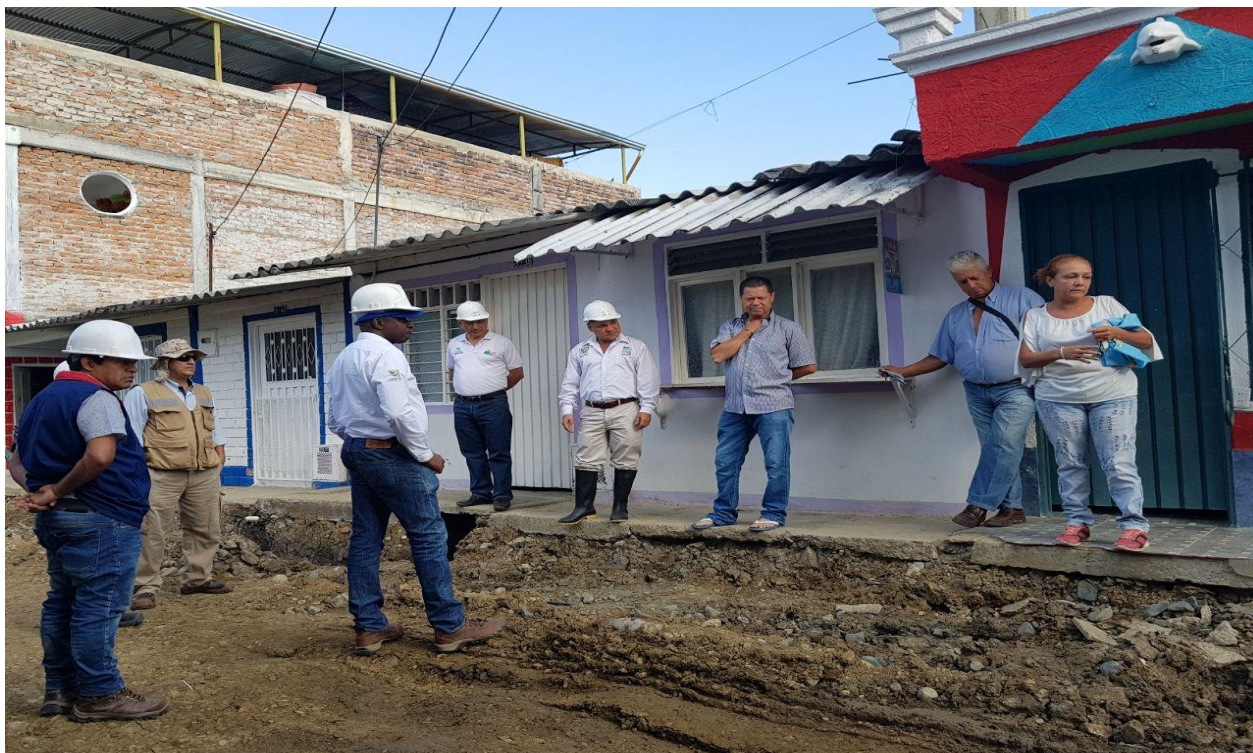
Foto Vallecaucana de Aguas/Obra en ejecución Alcantarillado Corregimiento de Sonso
