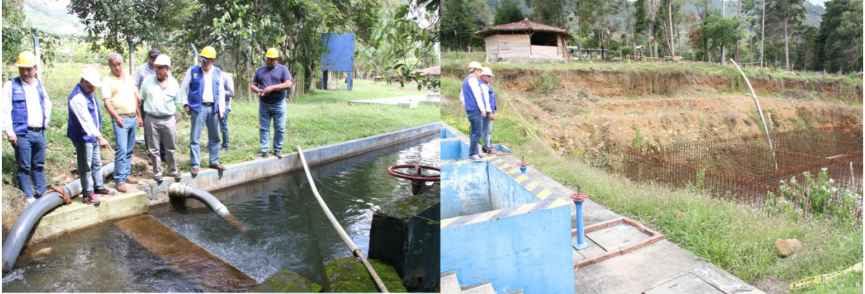
Foto Vallecaucana de Aguas / Visita de Inspección de obras de Vallecaucana de Aguas
