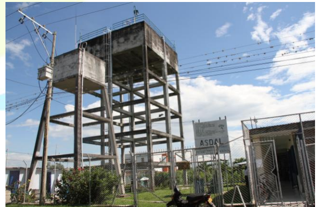
Foto Vallecaucana de Aguas/Acueducto Tres Esquinas-Tuluá, Valle del Cauca.
