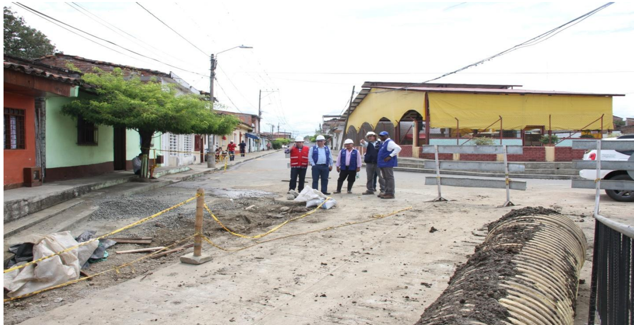
Foto Vallecaucana de Aguas/Visita obra alcantarillado de Sonso- Guacarí
