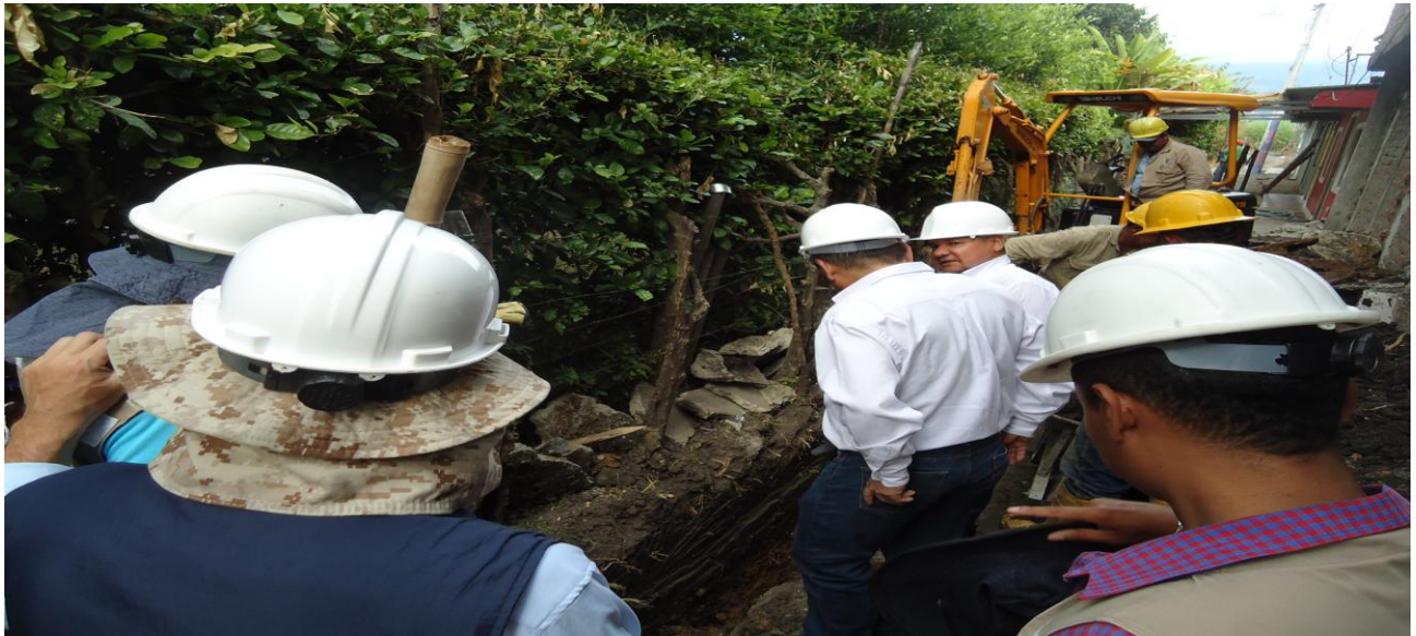
Foto Vallecaucana de Aguas/ Visita Técnica obra Alcantarillado –Sonso, Guacarí
