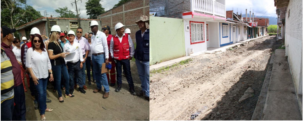
Foto Vallecaucana de Aguas / Recorrido Inspección obra Alcantarillado de Sonso- Guacarí
