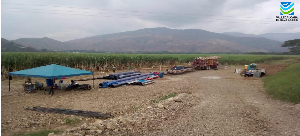
Foto /Vallecaucana de Aguas- Construcción pozo de agua –Vives Valle del Cauca
