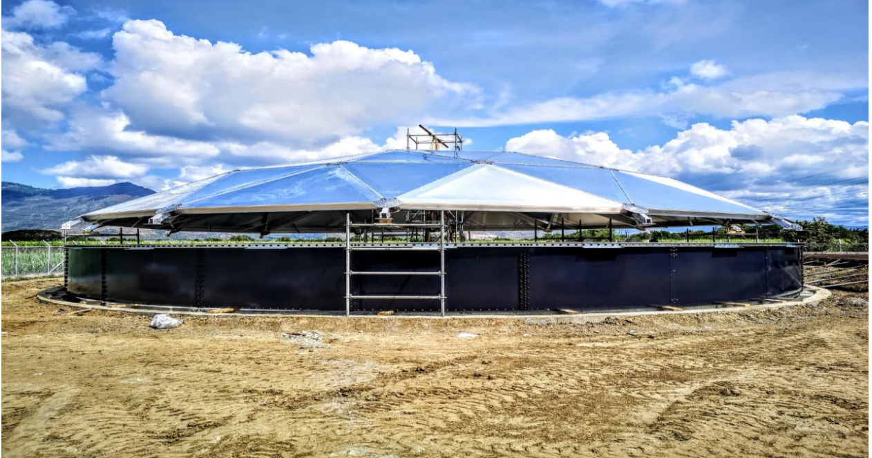
Foto /Vallecaucana de Aguas- Construcción Pozo de Yumbo
