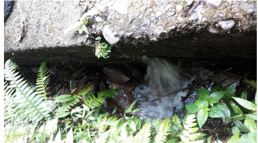
El canal es una estructura rectangular de hormigón. Su cota de borde se encuentra en la superficie del terreno, por lo tanto se trata de una estructura cerrada en su totalidad.
